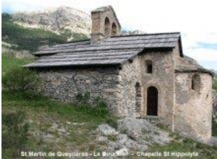
St Martin de Queyrières - Le Bouchier - Chapelle St Hippolyte
